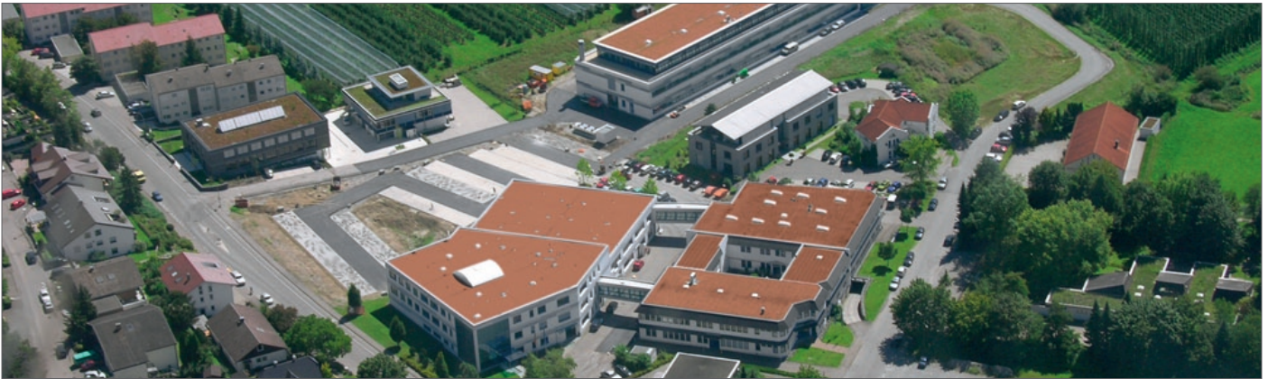
wenglor am Stammsitz Tettang: Das Forschungs- und Entwicklungsgebäude (rechts) ist direkt mit der Verwaltung und Fertigung verbunden (links). Auch das Logistik-, Vertriebs- und Schulungszentrum (oben) befindet sich in unmittelbarer Nähe.
